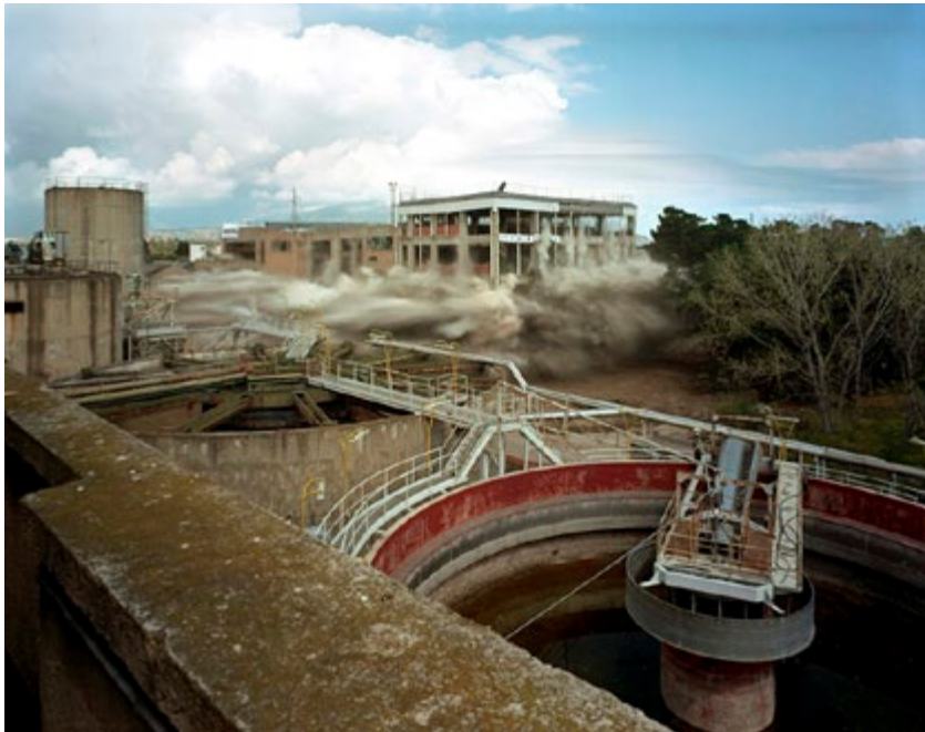
Viridis. Arbatax: demolizione
