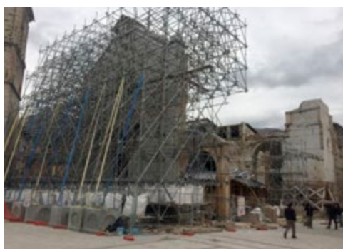
Figura 3. Il sopralluogo del Consiglio superiore nei laboratori di pronto intervento a Spoleto (in alto) e a Norcia (in basso).
