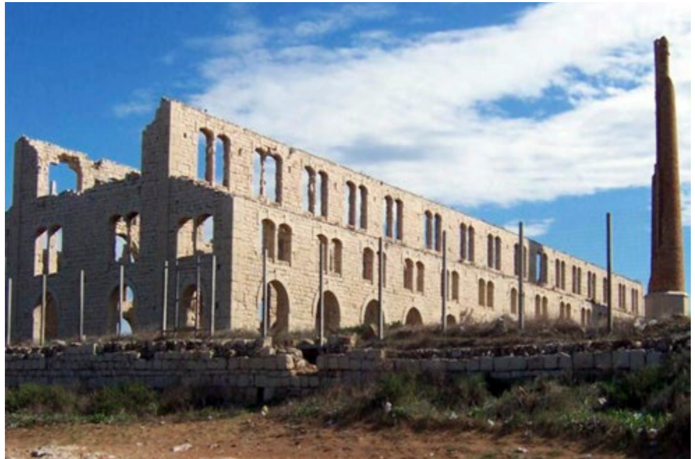
Fig. 2. La fornace Penna di Scicli (RG), le cui navate da cattedrale rappresentano uno dei casi più iconici di dismissione segnalati nel censimento "Riutilizziamo l'Italia". La foto, che appare in copertina del report qui presentato, è stata gentilmente concessa da Pippo Palazzolo, www.lealidiermes.net .
