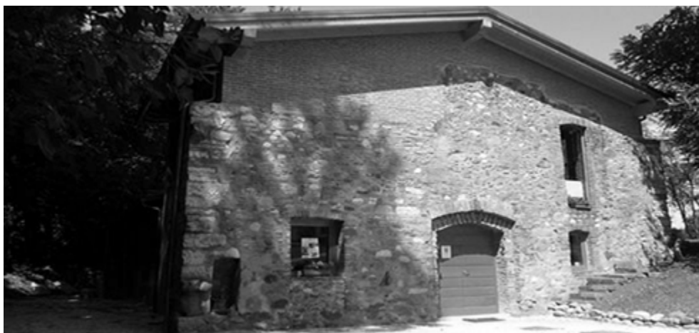
Fig. 1. Esterno del mulino ristrutturato (fonte: www.farinedelgarda.org ).
