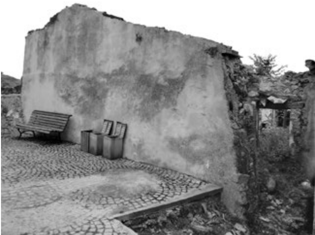
Figura 3. Riace, riqualificazione del manto stradale. Dietro, uno dei pochi edifici rimasti in stato di abbandono.
