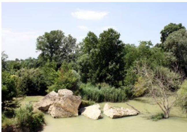
Figura 2. Torre Moro, Ortona (CH). I resti della struttura, edificata nel XVI secolo a difesa della fascia costiera, sono collassati nel fiume Moro (foto di A. Colecchia, Giugno 2016).
