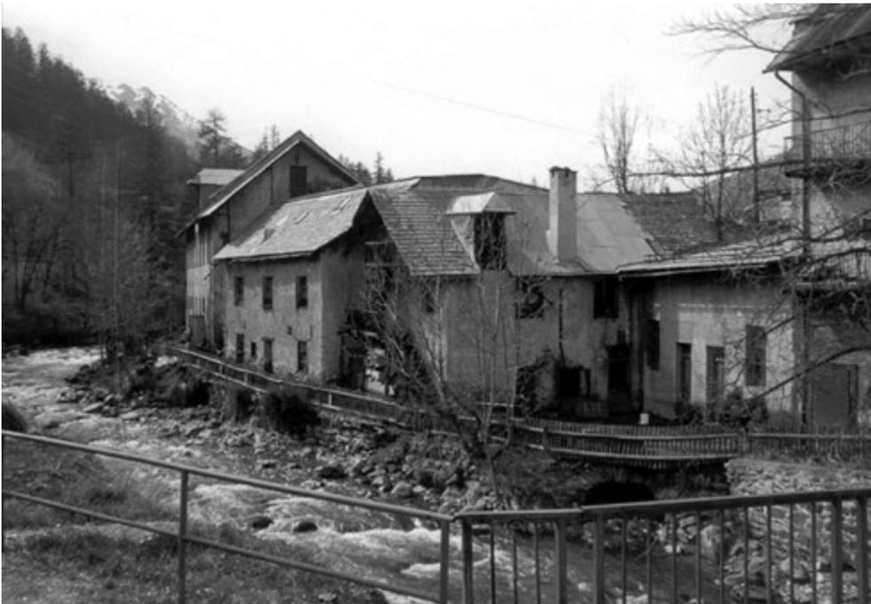
Fig. 6. Alla Filature de Chanterle, presso Briançon, le macchine per la trasformazione della lana (cardatura, filatura, follatura, lavaggio, tessitura etc.) sono alimentate dalla corrente della Guisane, trasformata in energia elettrica da una turbina.
