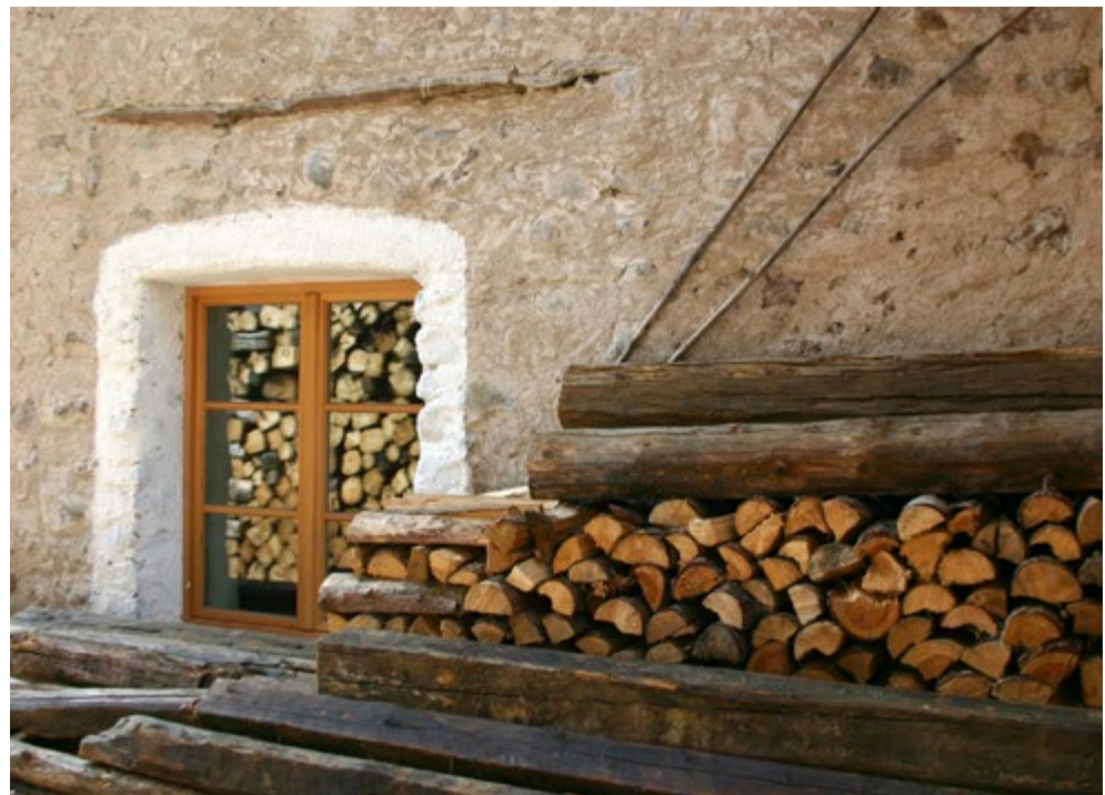
Fig. 1. Pordenone, particolare della finestra rinforzata di un manufatto recuperato.
