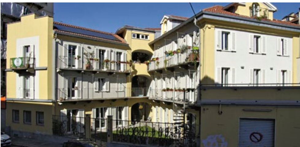
Fig. 4. L'edificio del co-housing dopo la ristrutturazione.
