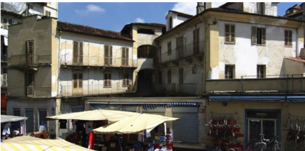
Fig. 3. L'edificio del co-housing come si presentava prima della ristrutturazione.
