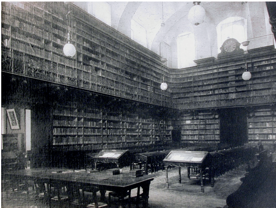
Fig. 18. Locali della sede di via Po ricostruiti dopo l'incendio del 1904, MiBACT, Biblioteca nazionale universitaria di Torino®.
