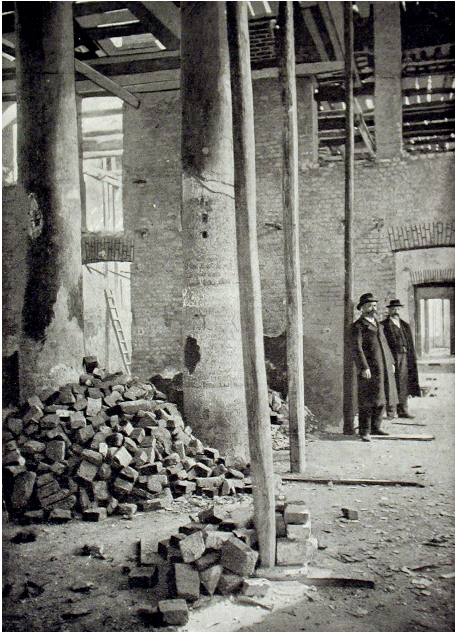
Fig. 5. Ispezione ai locali il giorno dopo l'incendio, MiBACT, Biblioteca nazionale universitaria di Torino ® .
