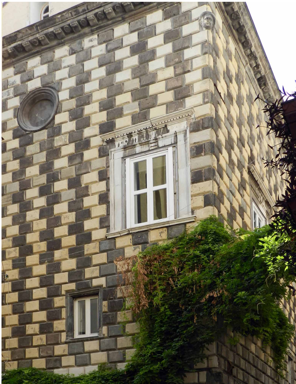
Fig. 4 Napoli, Palazzo Diomede Carafa. Dettaglio dell'esterno (foto B. de Divitiis).
