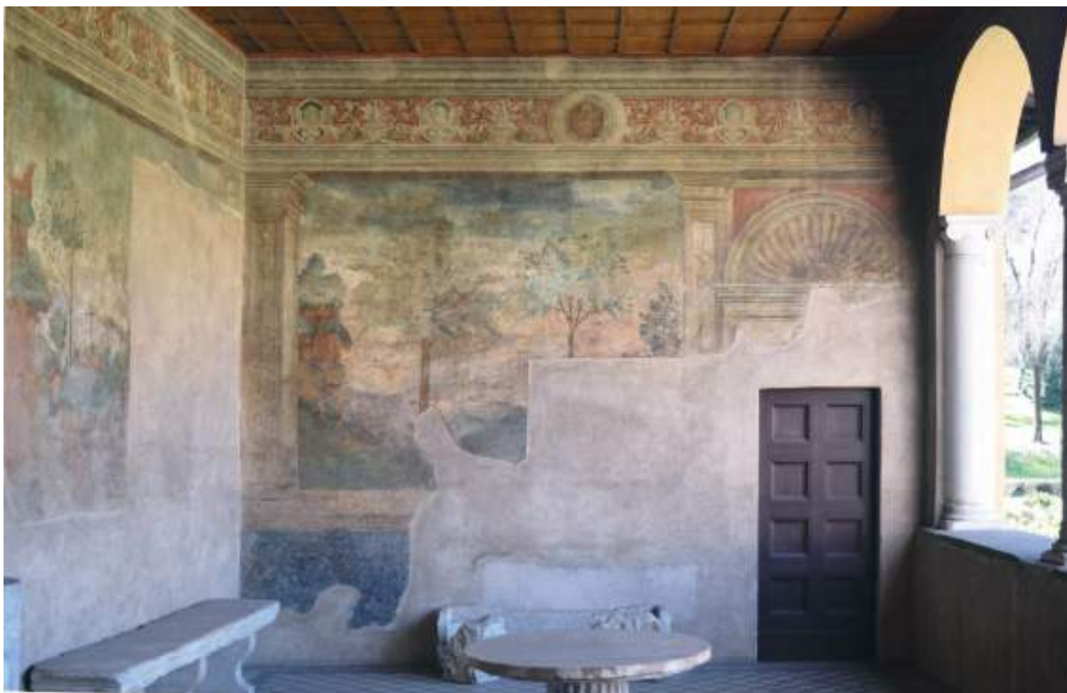
Fig. 14 Casina di Bessarione, Roma. Foto della parete occidentale.
