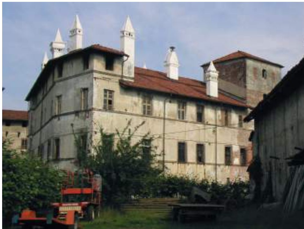
Figg. 17, 18 Castelli Tapparelli di Lagnasco, Lagnasco. Facciate nord e est del castello di ponente detto "palazzo bianco".
