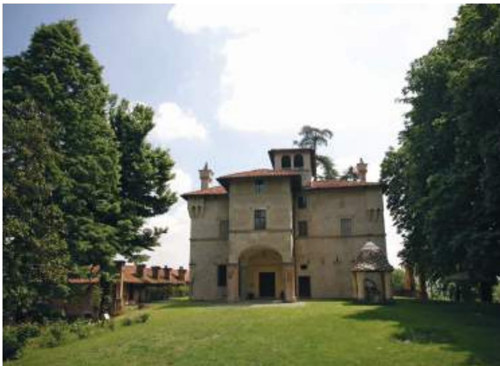
Fig. 4 Villa il Belvedere, Saluzzo. Prospetto principale.
