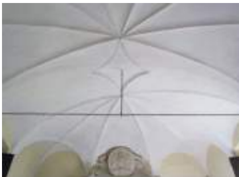
Fig. 6 Villa il Belvedere, Saluzzo. Volta ad ombrello al piano terra.
