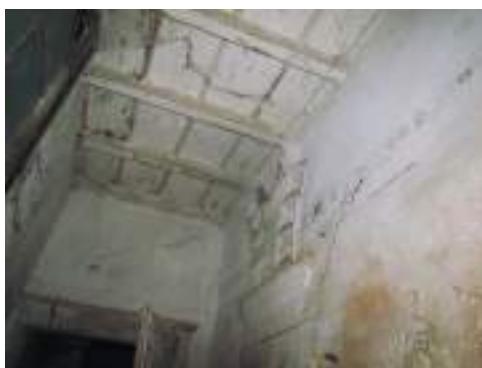
Fig. 11 Caselle Lomellina, Pavia. Parte di archivolto del fronte nord-est, nel piano terreno dell'edificio addossato.
