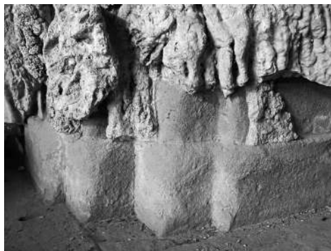
Fig. 4 Firenze, Villa medicea di Castello, Grotta degli Animali. Particolare dello zoccolo lapideo di base in corrispondenza dell'angolo ovest tra il braccio longitudinale e quello trasversale.
