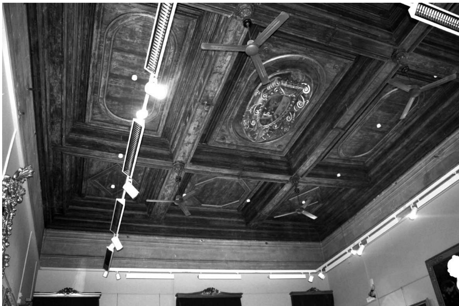
Fig. 4 Vista actual del techo lignario de la sala de planta noble del palacio Ramírez de Montalvo (fotografía C. Plaza).
