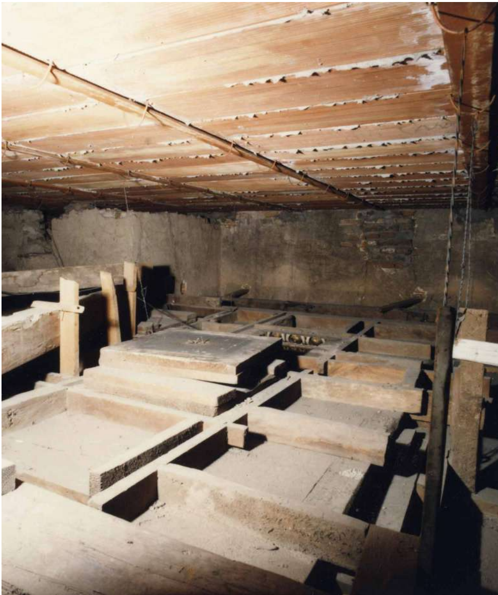
Fig. 5 Estradosso del soffitto della cappella dei Magi di palazzo Medici, Firenze (Archivio Fotografico della Soprintendenza Archeologia, Belle Arti e Paesaggio per la città Metropolitana di Firenze e le Province di Pistoia e Prato, n. 160783; 1991).
