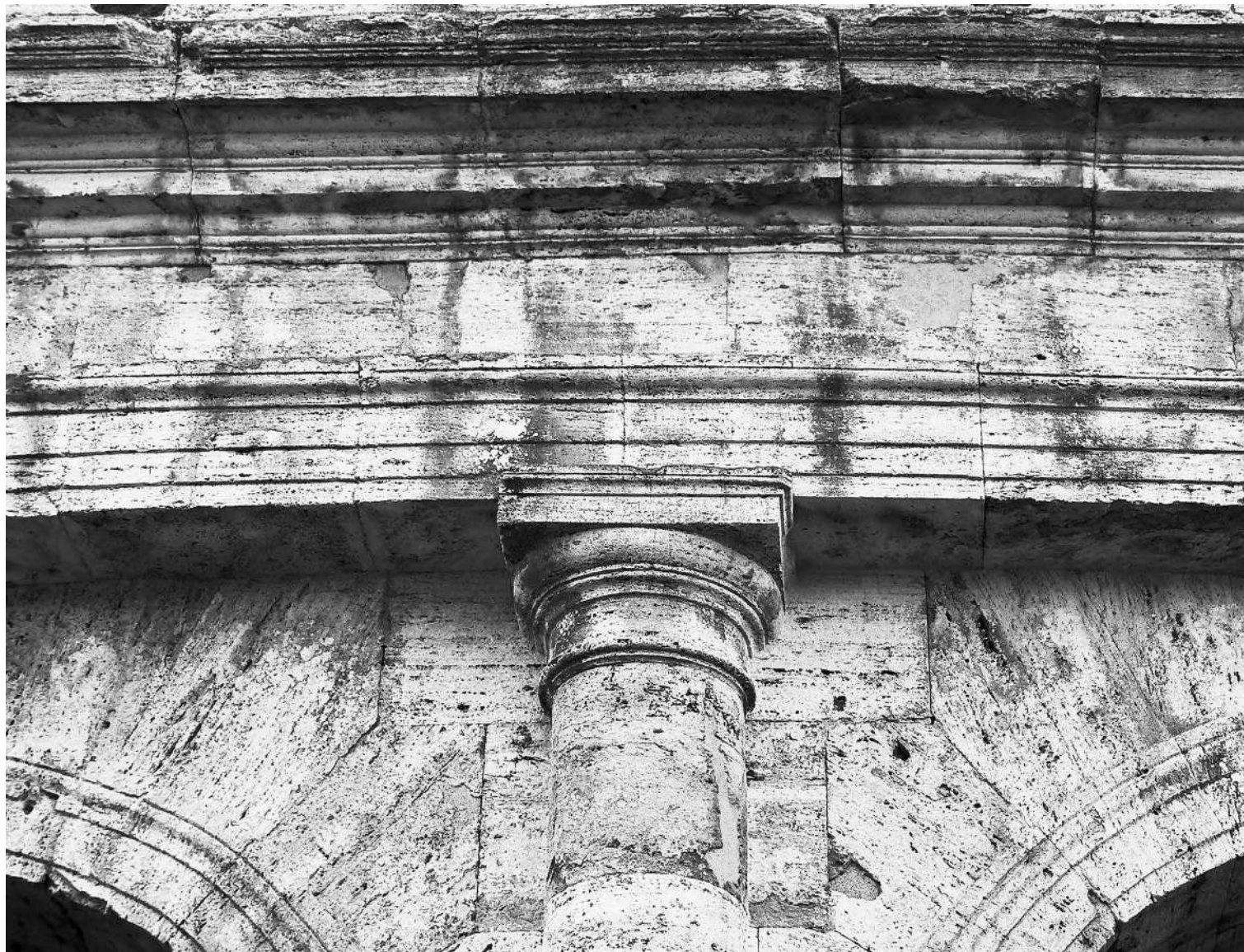
Fig. 5 Colosseo, Roma. Particolare di capitello e trabeazione.
