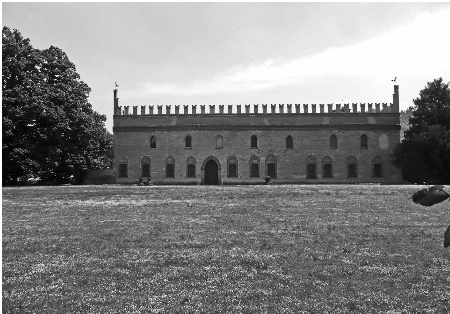
Fig. 8 Villa Rossi, Pontecchio Marconi (Bologna). Veduta da ovest.
