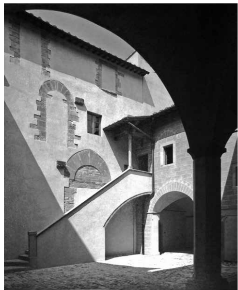
Fig. 8 Il Casone, Sorgane, Firenze. La corte (da Cini, Il restauro... cit., 1987).
