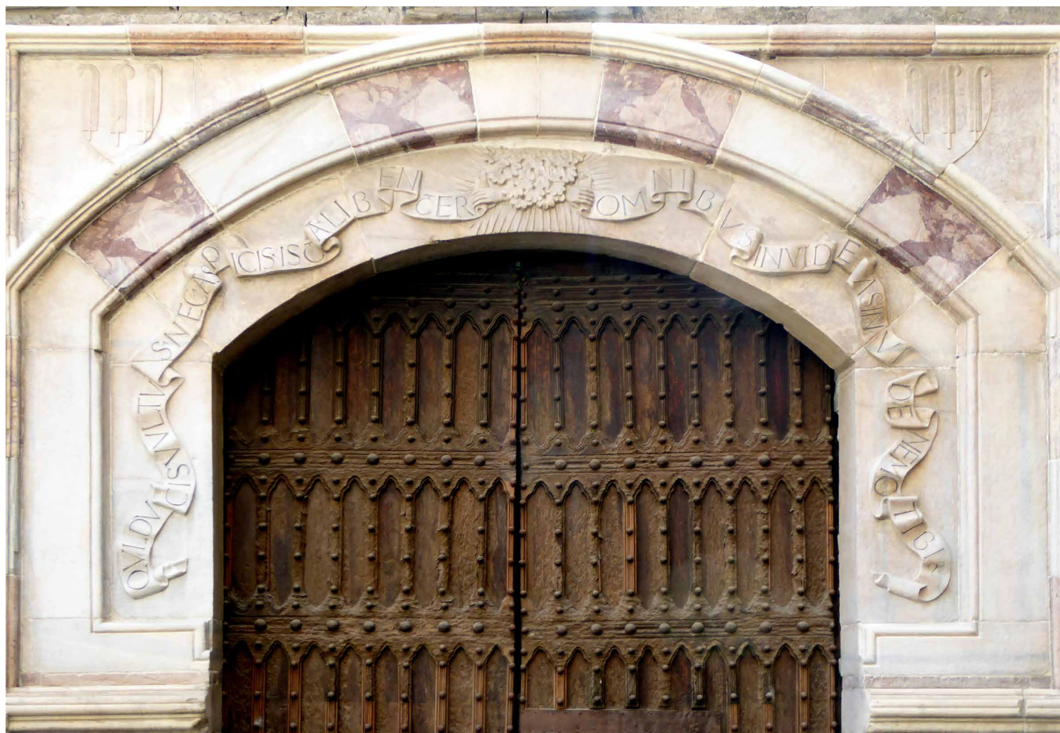
Fig. 10 Napoli, Palazzo Penne. Dettaglio del portale (foto F. Lenzo).
