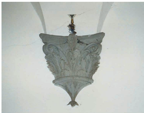
Fig. 6 Villa La Luna, San Domenico, Fiesole. Peduccio della sala a piano terreno, lato lungo.
