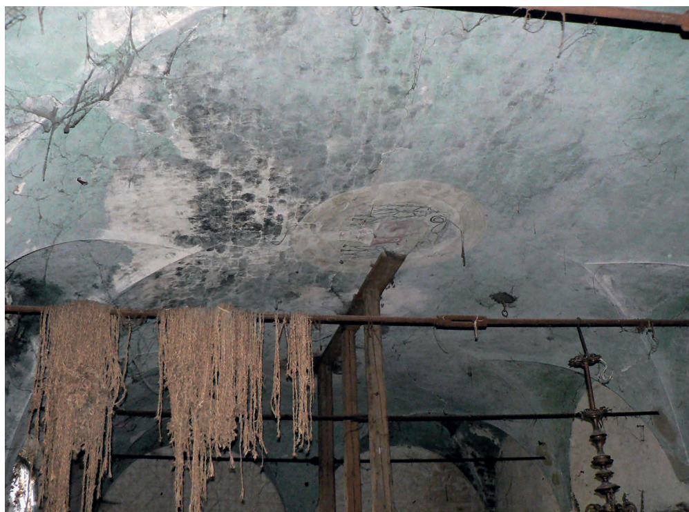
Fig. 4 Caselle Lomellina, Pavia. Volta affrescata dell'ambiente a pianta quadrata al piano terreno.
