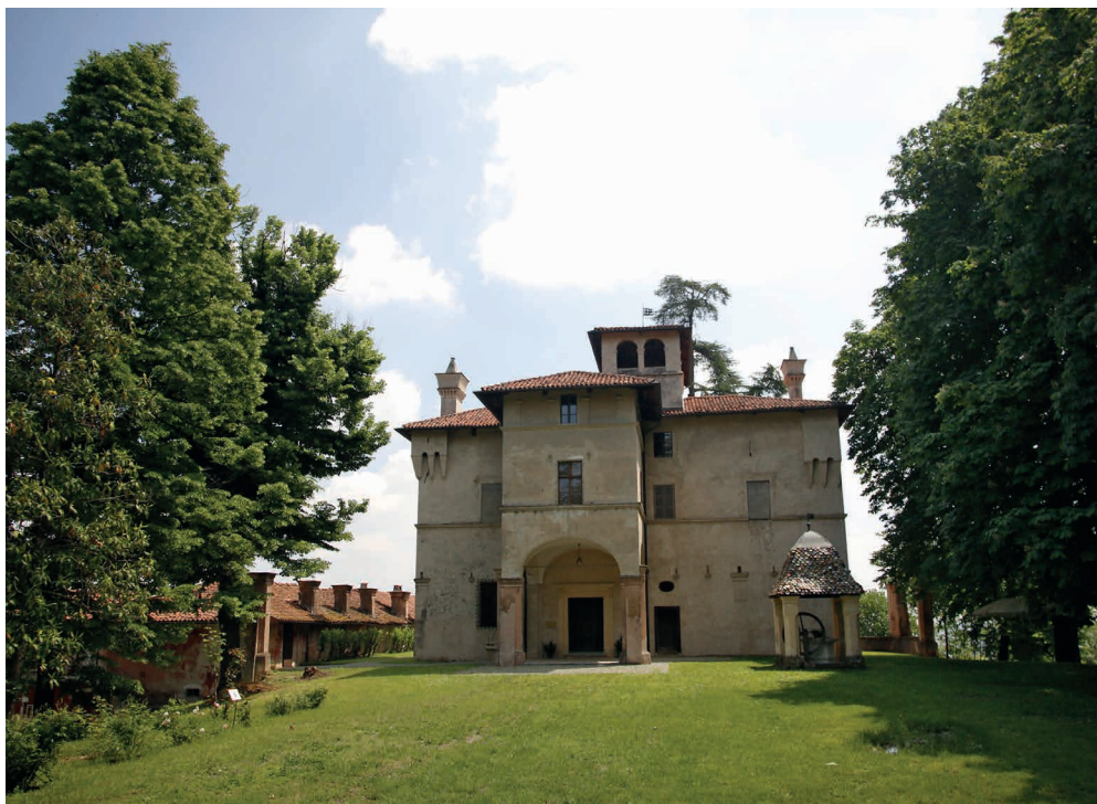
Fig. 4 Villa il Belvedere, Saluzzo. Prospetto principale.
