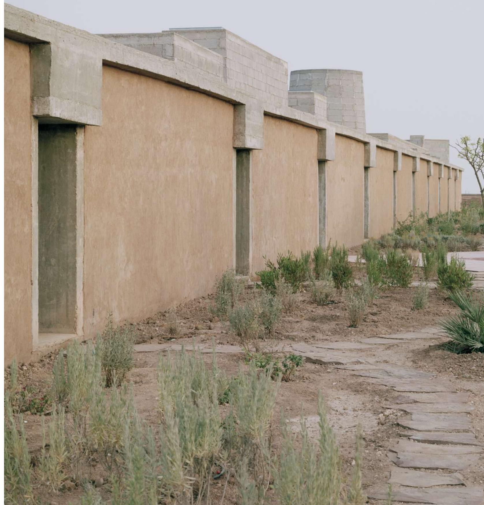
più, quella capacità dell'uomo di plasmare un intero paesaggio attraverso il controllo delle risorse naturali: energia solare, terra e acqua rendono questa costruzione completamente indipendente e autosufficiente.
