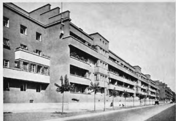
Teilansicht der Fassadenfront Borschstraße
