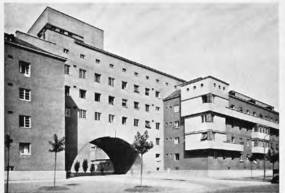
Fassadenpartie an der Ueberbrückung Halterastraße
