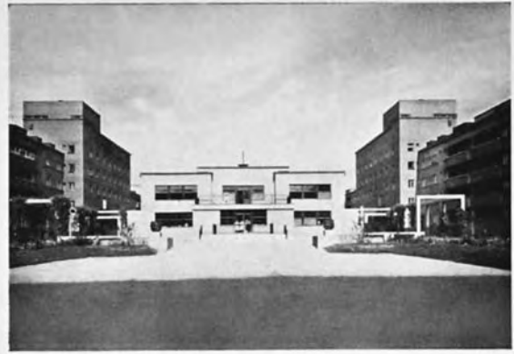
Blick auf den nördlich gelegenen Kindergarten
