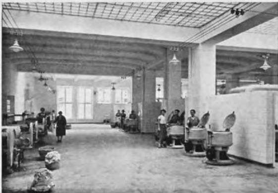
Aus der Zentralwäscherei (Blick in den Waschsaal)
