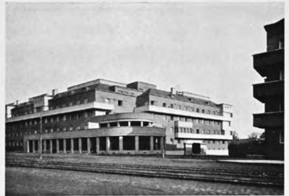
Ansicht der Front Geistingergasse, Ecke Heiligenstädter Straße
