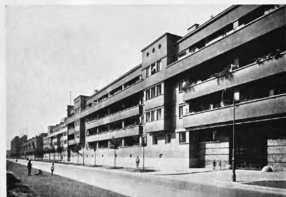
Teilansicht der Fassadenfront Borschstraße
