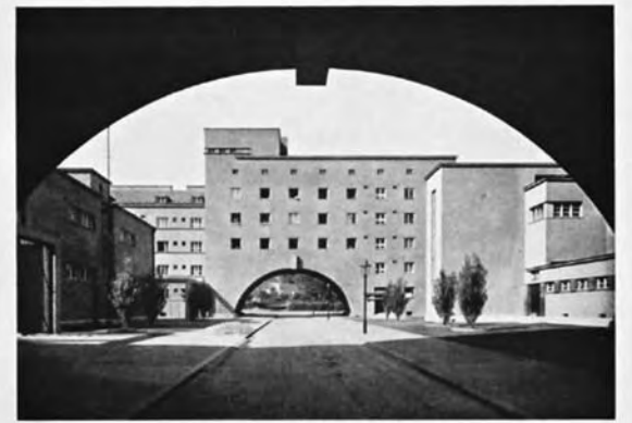
Ueberbauung der Halterastraße, links im Vordergrund das Kindergartengebäude, rechts vorne die Zentralwäscherei
