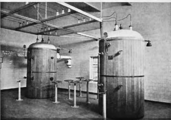
Aus der Zentralwäscherei (Elektrokessel im Schaltraume)
