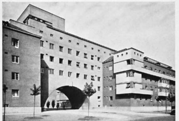
Fassadenpartie an der Ueberbrückung Halterastraße
