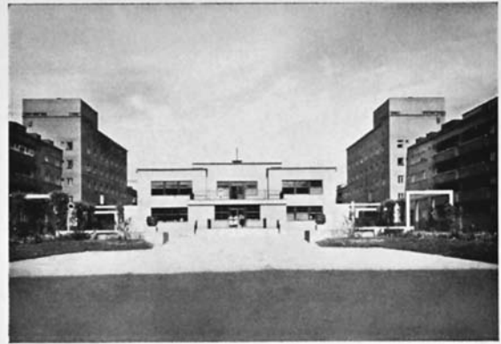
Blick auf den nördlich gelegenen Kindergarten
