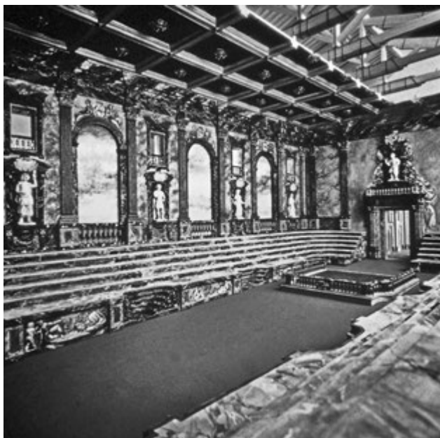
Fig. 19. Ipotesi di ricostruzione del fiorentino teatro Mediceo degli Uffizi con l'apparato buontalentino del 1589: veduta della sala (Ludovico Zorzi-Cesare Lisi 1975. Provincia di Firenze).
