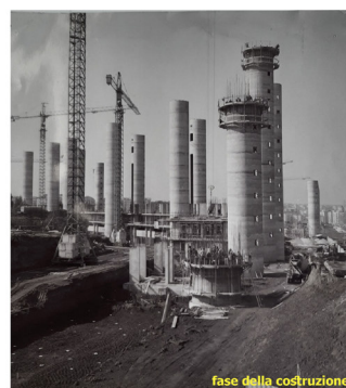
fase della costruzione
