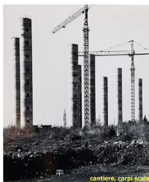
cantiere, corpi scala
