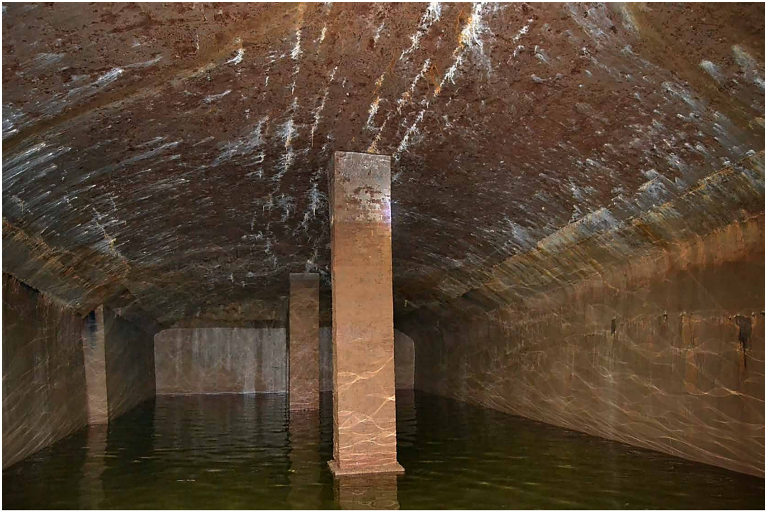
Cisterna di stoccaggio settecentesca ipogea presso la villa di Montegufoni (Montespertoli)
