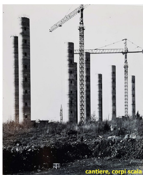
cantiere, corpi scala
