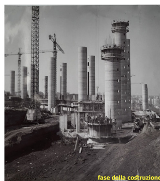
fase della costruzione
