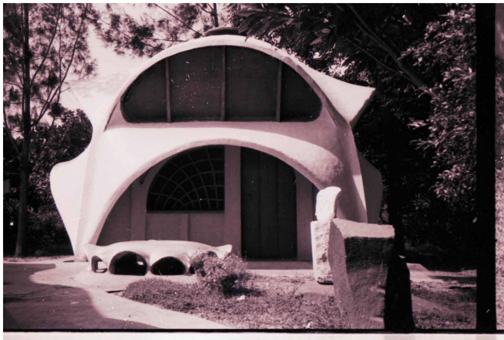
Fotografia storica non datata (anni '70) raffigurante un insediamento costruito seguendo una tecnica costruttiva locale basata sull'uso congiunto di canne e calce.
