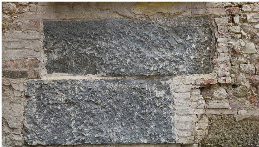
Particolare della muratura di villa Nuti, presso Lucardo (Montespertoli), con l'utilizzo di monoliti in pietra serena
