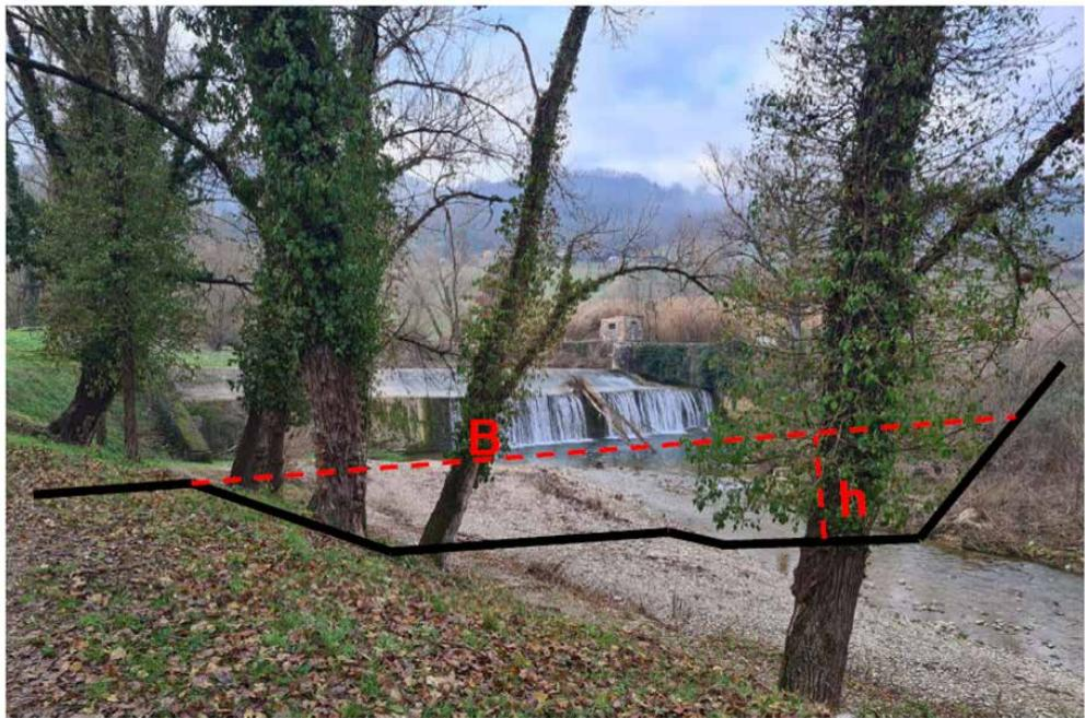
**Area di saggio n. 4 in località Ponterotto, caratterizzata da diametri rilevanti della vegetazione (oltre 50 cm) e da un rapporto tra la larghezza della sezione (B) e il tirante idrico (h), definito rapporto di forma (rf)  $rf=B/h$ , superiore a 10**
