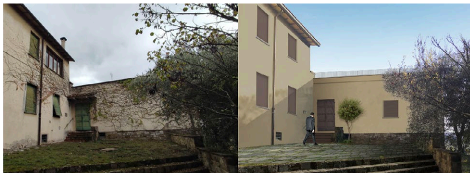
Figura 1. Vista del Villino Abetti prima dell'intervento (sinistra) e come sarà dopo la ristrutturazione (destra). Figure 1. A view of Villino Abetti before work began (left) and how it will look after renovation (right).
