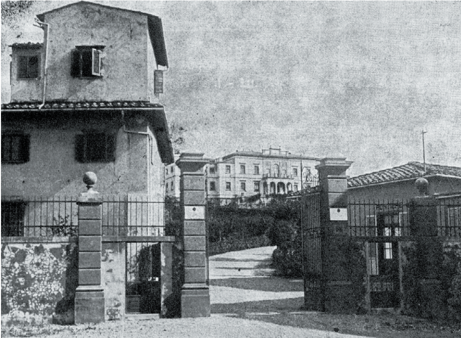
Figura 6. Come si presentava l'ingresso al colle di Arcetri subito dopo l'inaugurazione. L'aspetto attuale è quasi identico, a parte la vegetazione.
