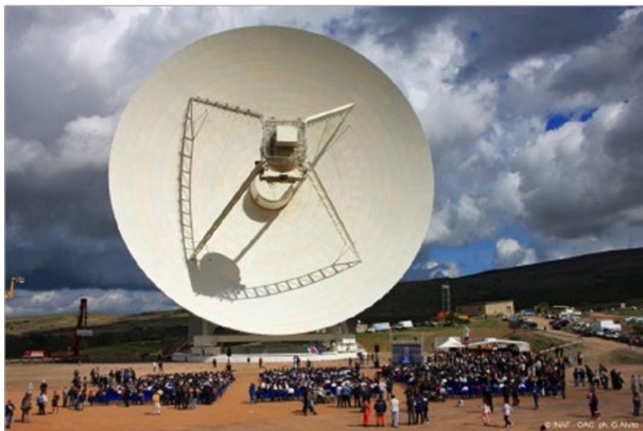
Fig. 1. Cerimonia inaugurale del nuovo impianto scientifico sardo alto 70 m e pesante 3000 tonnellate dotato di due sistemi indipendenti di movimentazione per osservare qualsiasi direzione del cielo.
