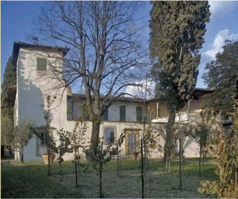
Fig. 1. Vista di Villa il Gioiello. Fig. 1. View of Villa il Gioiello.
