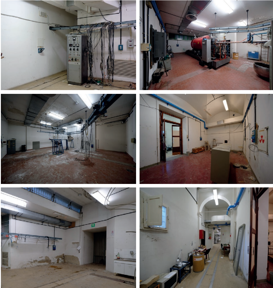
Figura 7. Lo stato dei locali utilizzati dalla fisica nucleare al “Garbasso”, contenenti l’acceleratore KN3000, la sala misure e acquisizione dati, prima dell’intervento di restauro e allestimento museale.
