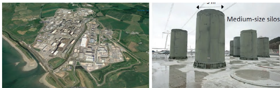
Figura 7. Vista aerea dell'impianto di Sellafield (sinistra) e alcuni silos per lo stoccaggio dei rifiuti (destra). Figure 7. Aerial view of the Sellafield site (left) and some waste storage silos (right).
