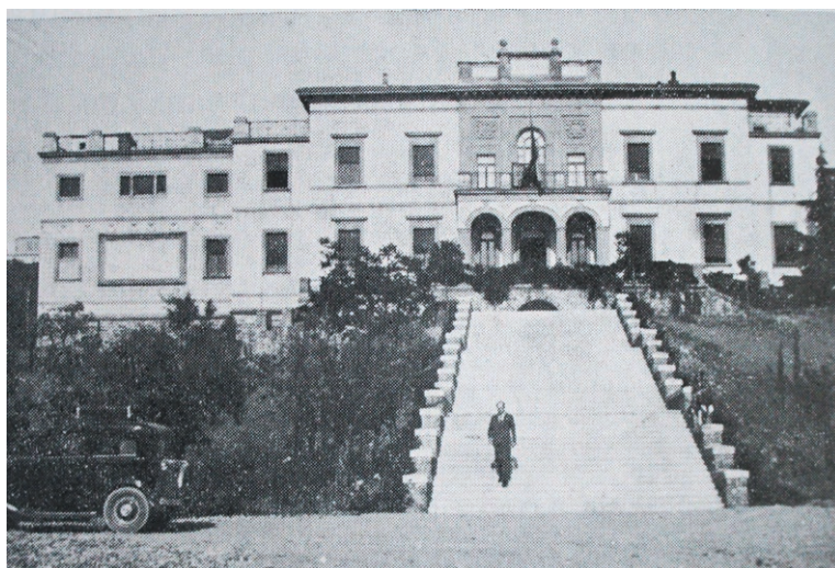
Figura 5. Il terrapieno e la "scalinata monumentale", che furono motivo sia del prolungamento dei lavori, sia della lievitazione dei costi.
