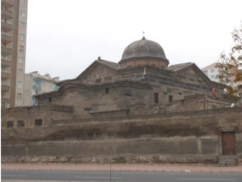
1 - Chiesa di Surb Krikor Lusavorich (2014), Kayseri
