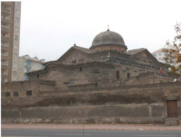
1 - Chiesa di Surb Krikor Lusavorich (2014), Kayseri
